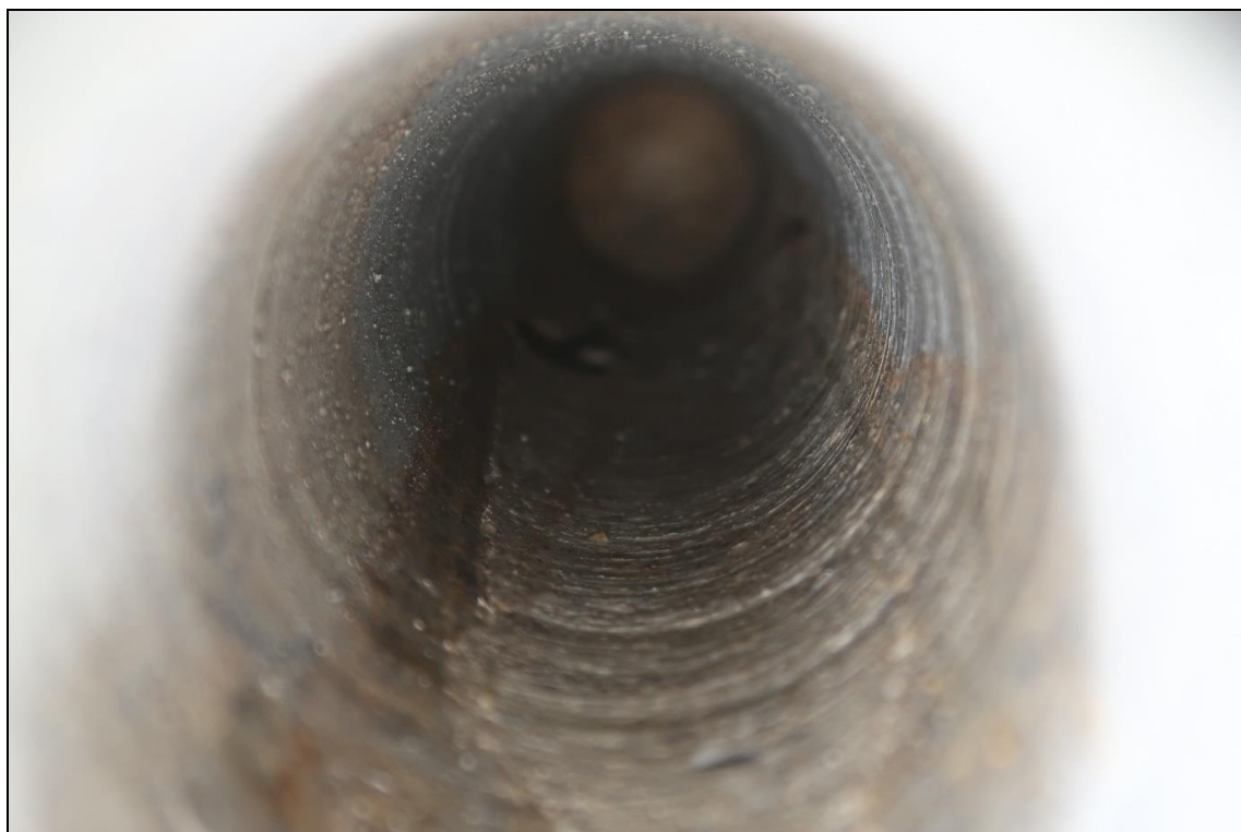
Foto 20: Pohled do vývrty V4, ložná spára (dole) je zcela vyplněna maltou/betonem
