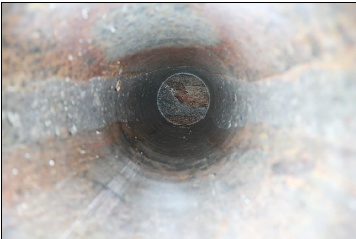
Foto 7: Pohled do vývrtu 2, ložná spára je zcela vyplněna maltou/betonem (v celé hloubce), na konci vývrtu se výrazně rozšiřuje
