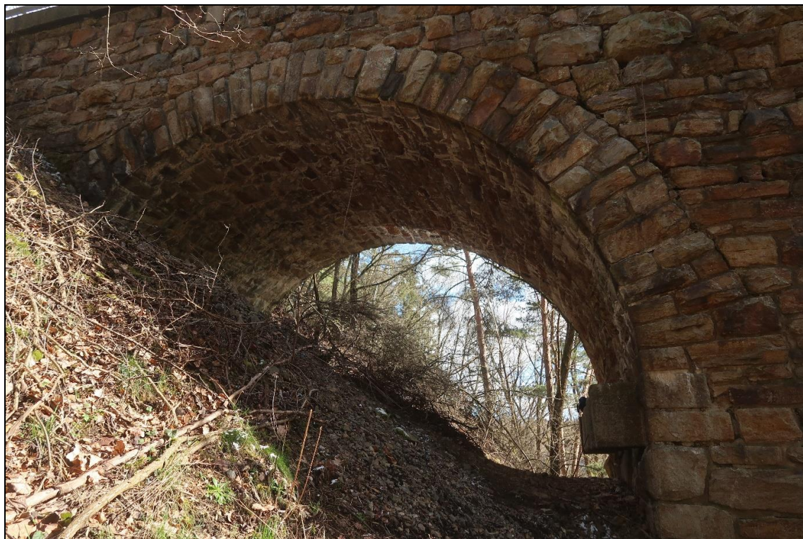
Foto 17: Pohled na pole 10 na straně směrem k Božejovicím, pole se nachází ve velmi strmé straně, část klenby (cca \frac{1}{4} ) je zasypána
