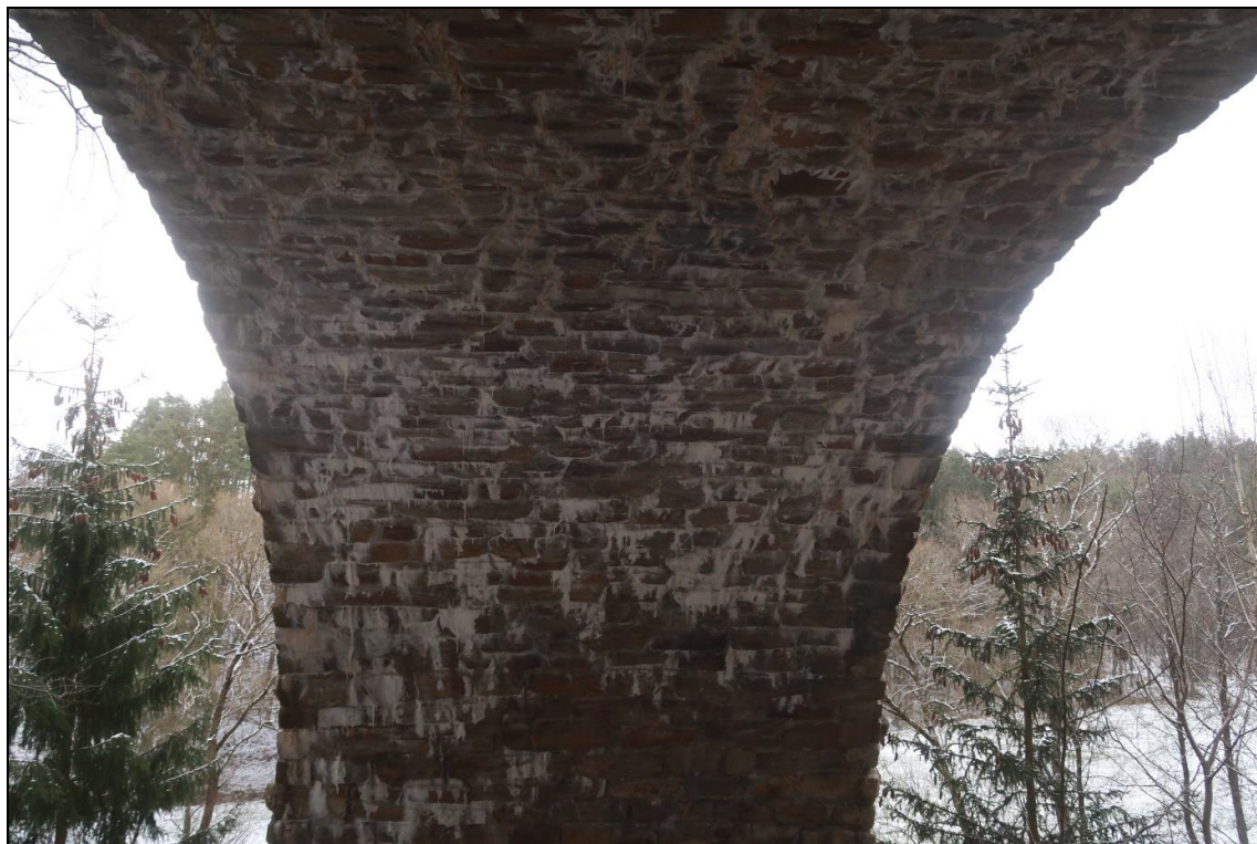
Foto 3: Pohled na dolní líc klenby 1, strana směrem k Sepekovu, lícová strana klenby je pokryta výluhy ze spár, pravděpodobně se jedná o výluhy kalcitu
