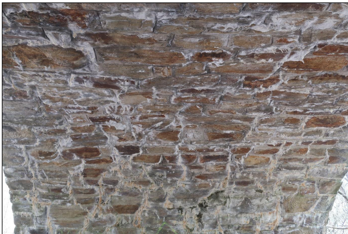
Foto 18: Dolní líc klenby pole 10, celý dolní líc je pokryt výluhy (kalcitu)
