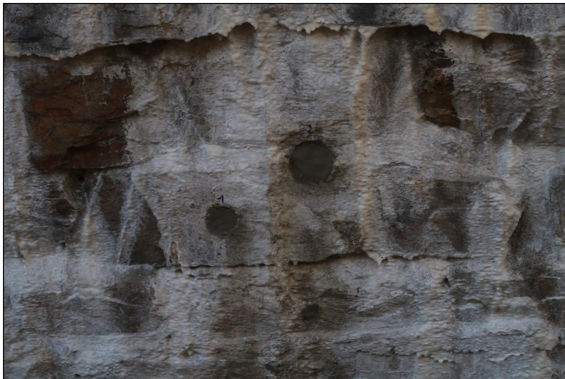
Foto 11: Vývrt V1 a V2 po sanaci PCC maltou
